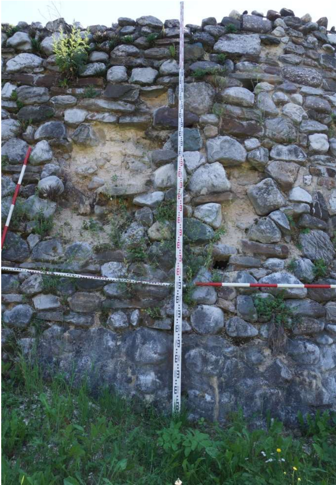
ОГРАДНИ ЗИД КОМПЛЕКСА-ОШТЕЋЕЊА И ДЕГРАДАЦИЈЕ
