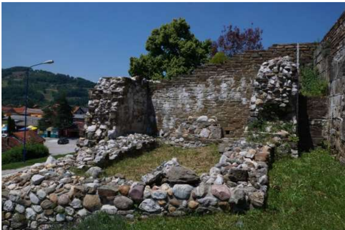
ОСТАЦИ ГРАЂЕВИНА СА ЗАПАДНЕ СТРАНЕ КОМПЛЕКСА-ОШТЕЋЕЊА И ДЕГРАДАЦИЈЕ
