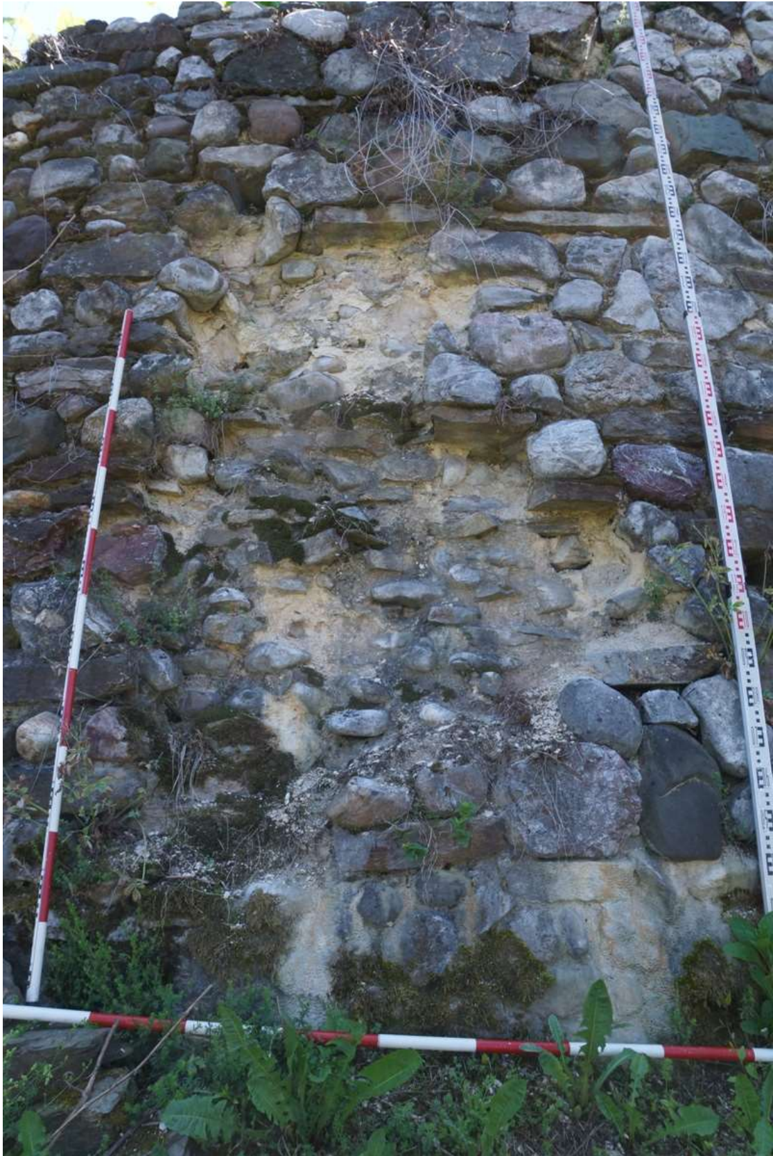
ОГРАДНИ ЗИД КОМПЛЕКСА-ОШТЕЋЕЊА И ДЕГРАДАЦИЈ ОГРАДНИ ЗИД КОМПЛЕКСА-ОШТЕЋЕЊА И ДЕГРАДАЦИЈЕ
